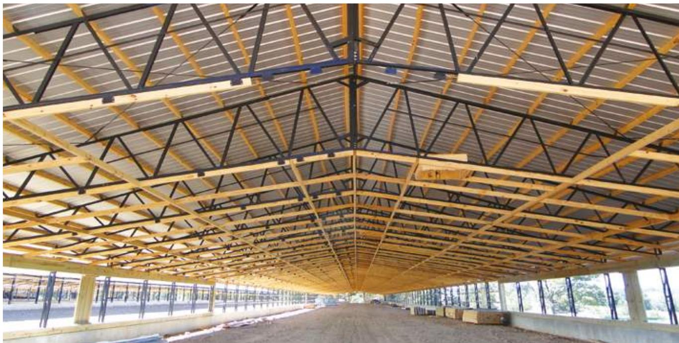
Este estilo de construcción maximiza la eficiencia del sistema de ventilación de túnel gracias a la calidad del aislamiento y la estanqueidad que provee.
