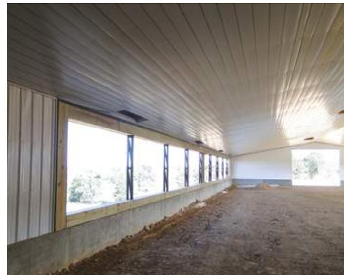
Un buen aislamiento térmico del techo del galpón mediante un cielorraso suspendido acota el volumen del aire a climatizar. Esto se traduce en un menor consumo de energía eléctrica y gas.
