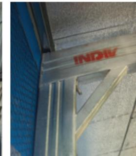
El cálculo estructural de los galpones **INDIV®** verifica el peso propio, las cargas de los componentes que se instalen en su interior y una velocidad de viento de hasta 130 km/h. Son fabricados en acero galvanizado por inmersión para máxima protección anticorrosiva. Por su configuración de ensamblado mecánico entre las piezas, no es necesario realizar soldaduras. Así se simplifica la construcción en el lugar siendo ésta rápida y sencilla.
