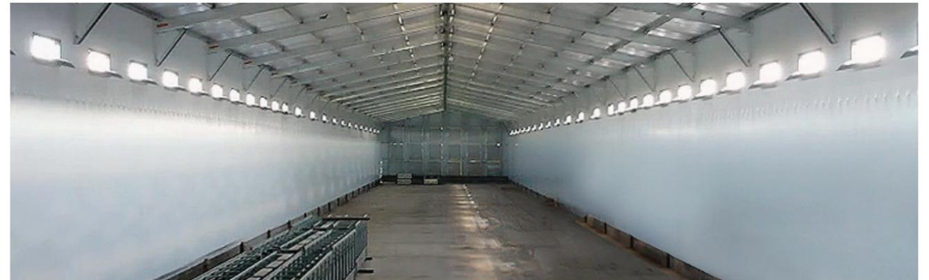
Construidos en vigas cajón de perfiles C conformados galvanizados. Este sistema constructivo garantiza rapidez de montaje, resistencia a ambientes corrosivos y una correcta limpieza, ya que no se generan intersticios para sedimentación de suciedad que afecte las condiciones de bioseguridad e higiene del galpón.
