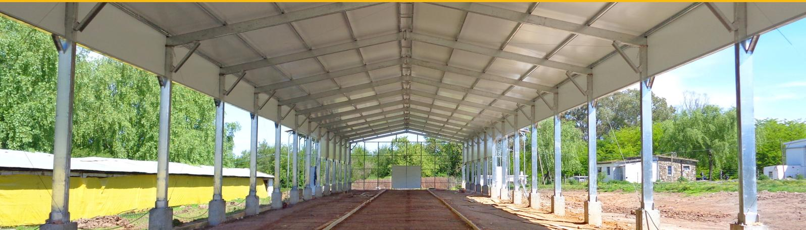
Construidas en vigas cajón de perfiles C conformados galvanizados. Este sistema constructivo **garantiza rapidez de montaje, resistencia a ambientes corrosivos** y una **correcta limpieza**, ya que no se generan intersticios para sedimentación de suciedad que afecte las condiciones de bioseguridad e higiene del galpón.
